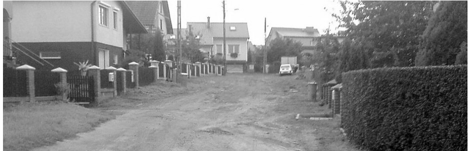
ul. Dygata: Brakująca, wypłukaną przez rotopy i padające deszcze część ulicy można znaleźć na ul. Broniewskiego.
