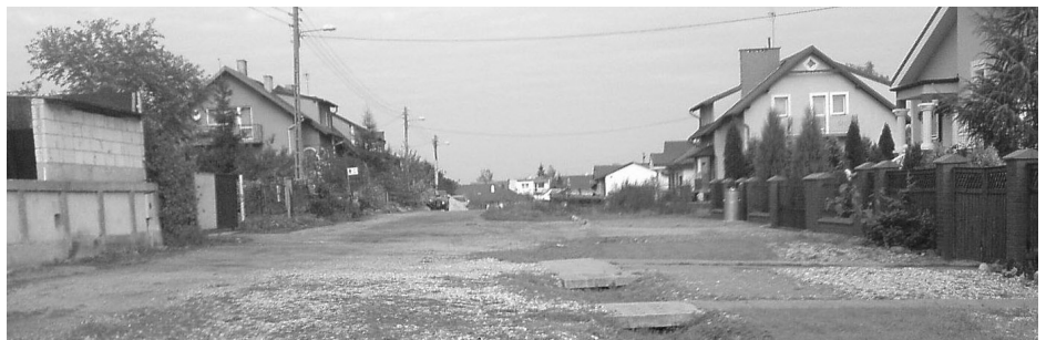
ul. Rzemieśnicza: Widoczne „wilcze doły”, częściowo tylko przykryte płytami mają swoją wieloletnią już historię. Czy przetrwają do następnej dekady? – pytają mieszkańcy.
